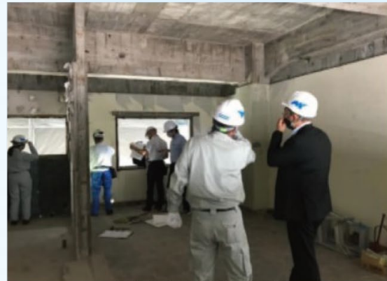
▲内装解体状況の確認
