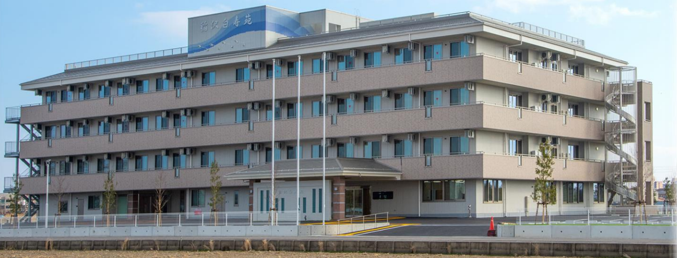
稲沢白寿苑 新築工事
