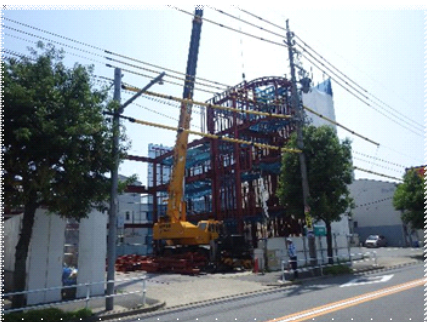
⑥ 鉄骨建方
