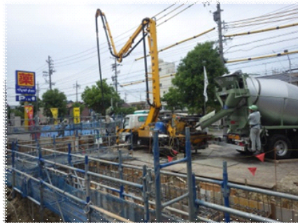
④ 基礎、地中梁コンクリート打設工事
