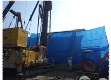
② 杭打設工事
