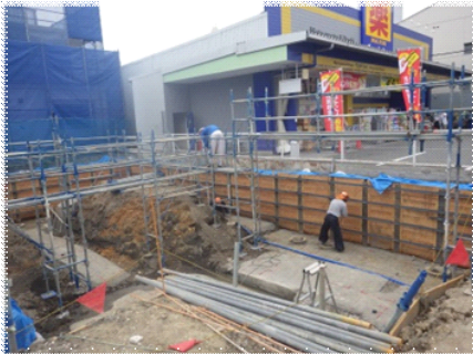
③ 基礎工事
