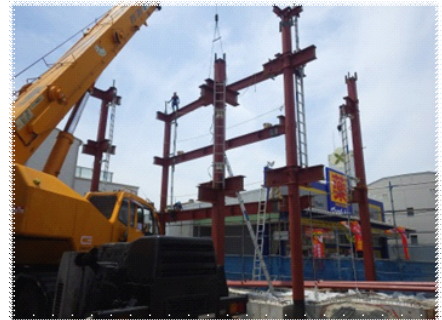
⑤ 鉄骨建方
