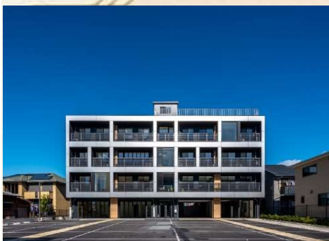
▲内藤建設株式会社 大垣支店リファイニング工事
