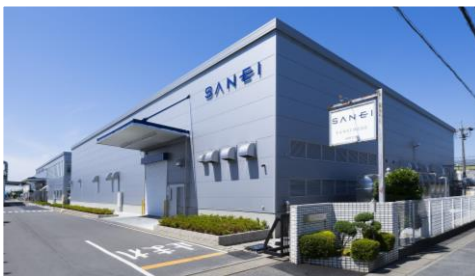
SANEI 株式会社様 岐阜第1工場拡張工事
