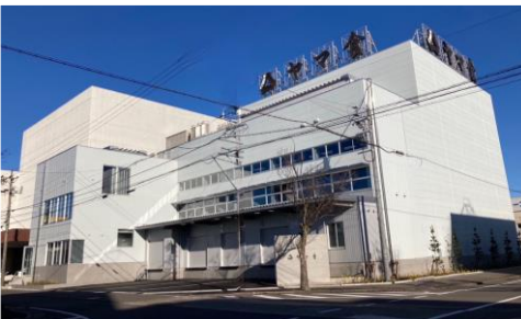
株式会社ヤマ食様 冷凍自動倉庫新築工事
